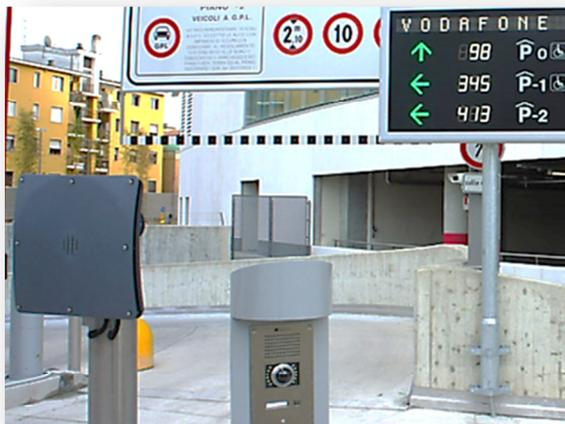
completamente conforme allo standard EPC Gen2 (ISO 18000-6C) e con Wide Range di lettura, fino a 9 metri di distanza e soprattutto un’alta flessibilità per lo sviluppo dei necessari software dedicati.
